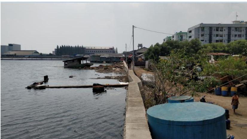
Il lungomare del distretto di Pluit a Jakarta in Indonesia, situato alcuni metri sotto il livello del mare e protetto da esso per mezzo di un muro di cemento che deve essere rialzato ogni pochi anni per contrastare una subsidenza di 10-20 cm / anno dovuto al sovrasfruttamento della falda acquifera (foto di Pietro Teatini scattata il 20 settembre 2019).
