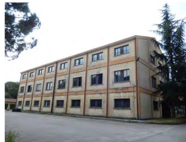
Edificio a tre piani in muratura intonacata con struttura in latero cemento; i piani sono evidenziati da un marcapiano e la copertura si presenta a due falde. L'edificio già presente nella seconda metà dell'800 è stato modificato negli anni '60 del 900 riportando l'attuale aspetto. Le facciate del lato lungo e del lato corto sono rispettivamente speculari e presentano una serie di forometrie regolari con gli accessi sui lati est e ovest.
