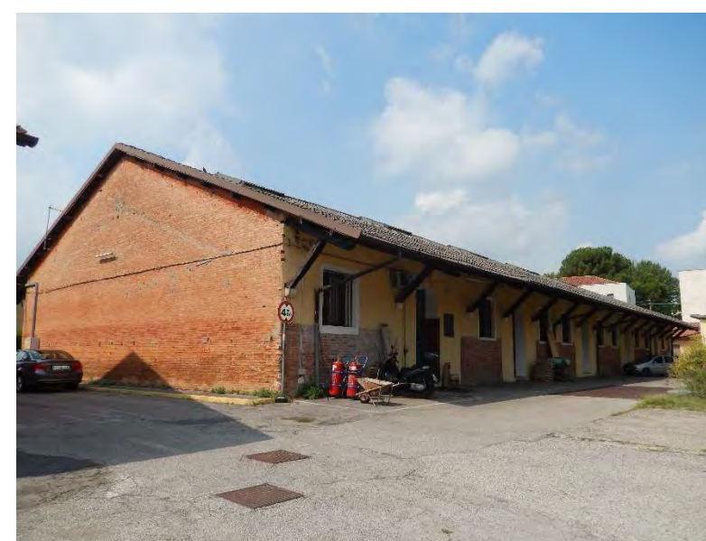
Lato nord est
