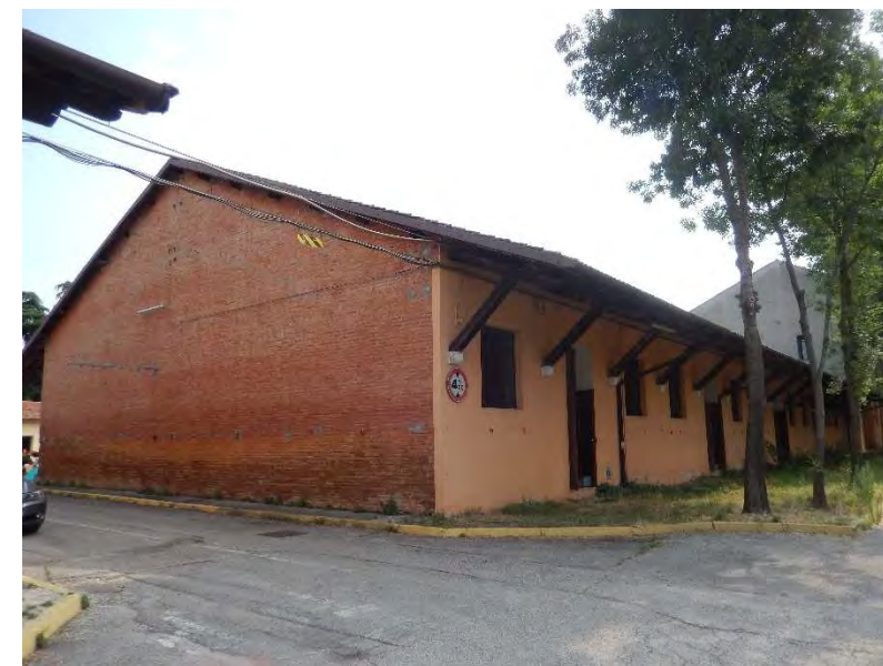
Lato sud ovest
