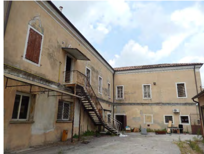
Lato nord ovest
