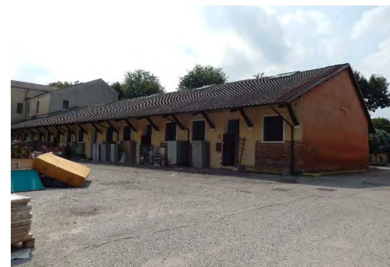
Lato nord ovest
