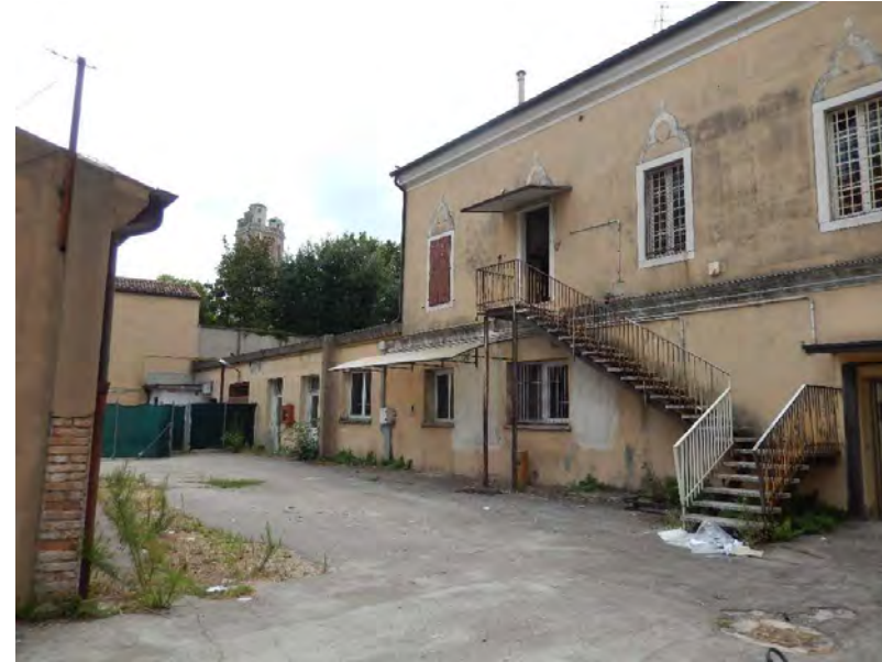
Lato nord est
