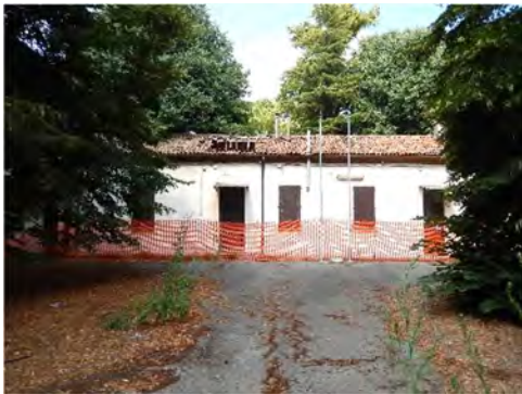
Lato ovest cortile
