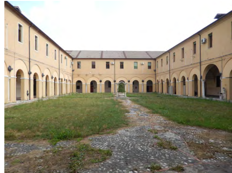
Lato nord corte
