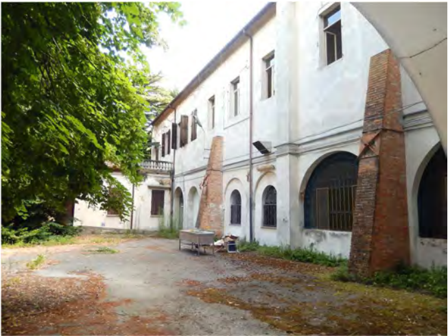
Lato est cortile
