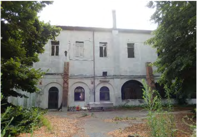
Lato est cortile
